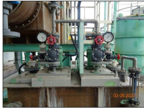
ภาพที่ 2.2-4 ป้อนน้ำที่ใช้ในระบบ Wet Scrubber
