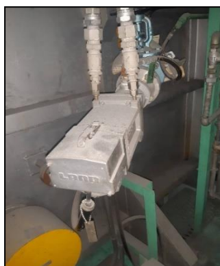
ภาพที่ 2.2-52 การติดตั้งอุปกรณ์ตรวจวัดอัตโนมัติ เพื่อตรวจวัดอุณหภูมิ/ความร้อน ภายในเตาอบ
