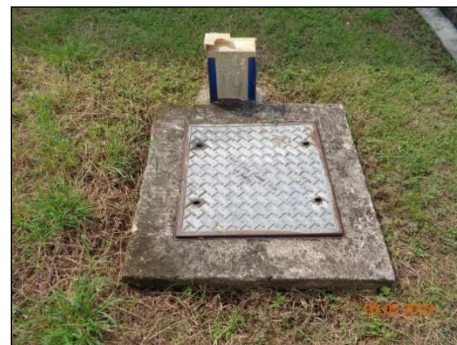
ภาพที่ 2.2-11 ถังบำบัดน้ำเสียสำเร็จรูป
