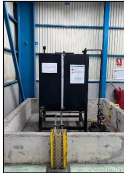
ภาพที่ 2.2-3 ถังสำรองน้ำมันดีเซล
