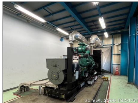
ภาพที่ 2.2-2 เครื่องกำเนิดไฟฟ้าสำรอง
