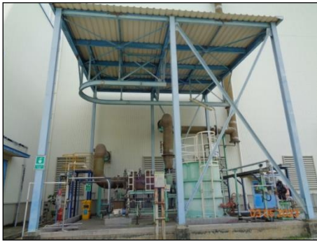
ภาพที่ 2.2-1 ระบบ Wet Scrubber
