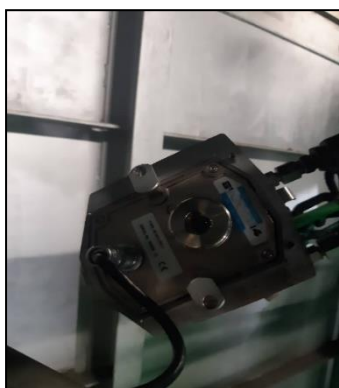
ภาพที่ 2.2-52 การติดตั้งอุปกรณ์ตรวจวัดอัตโนมัติ เพื่อตรวจวัดอุณหภูมิ/ความร้อน ภายในเตาอบ
